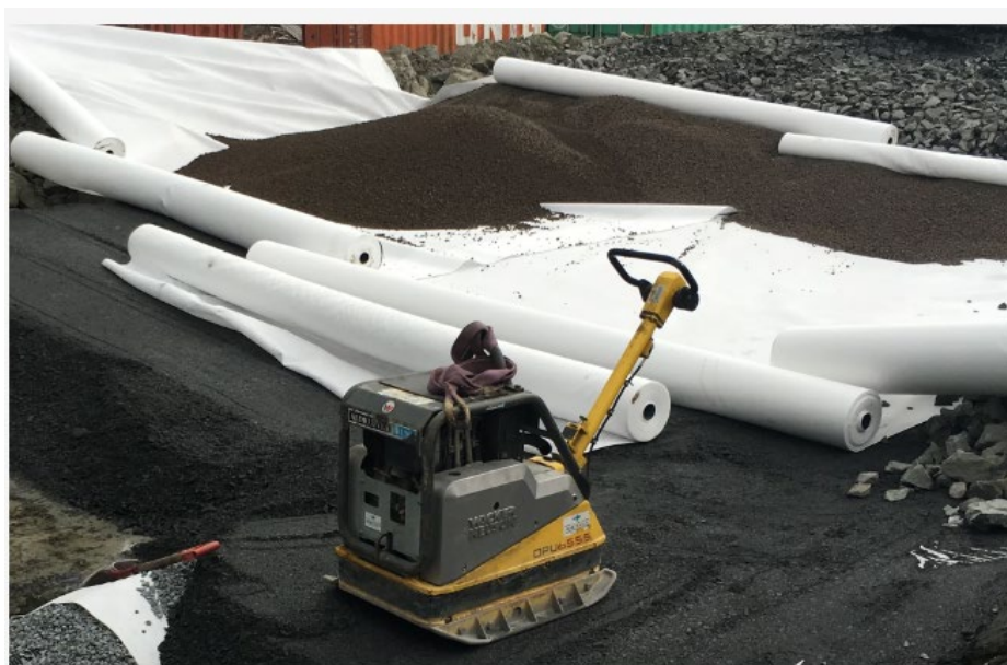
Figur 3: Bilde fra utlegging av lettlinkerfylling. (Foto: Trine Flobak, Rambøll)
