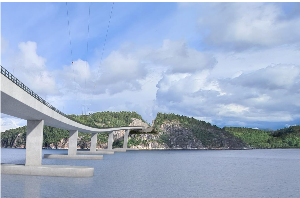
Figur 2-5 Illustrasjon av ny bru og vegskjæring gjennom Ølhammaren, sett i retning mot nordøst. Kilde: Norconsult.
