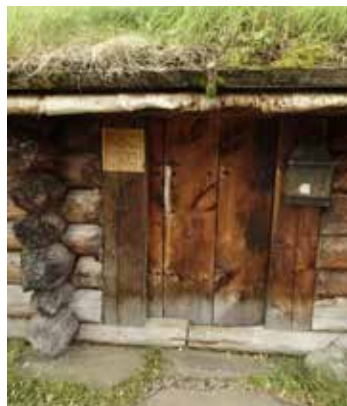
Labankdør med brede bord, Museumssetra, Synnerdalen
