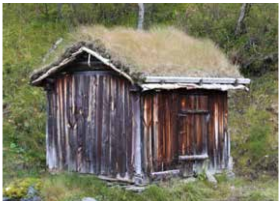
Avkjøling i grovt bindingsverk, Mastukåsen i Vangrøftdalen.
