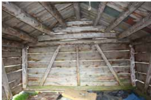
Grovt bindingsverk er en materialbesparende byggemåte.
