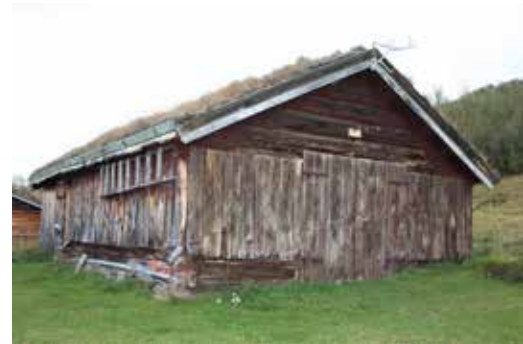
Skjelterkonstruksjon er mye brukt i fjøs, gjerne i kombinasjon med tømmer.
