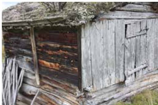
Her er det brukt både liggende og stående kledning på løe i skjelterkonstruksjon
