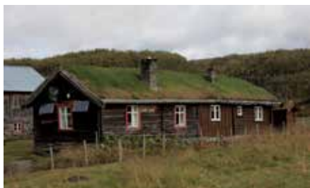
Tilbygg i lengden på Paurengvangen, Magnilldalen
