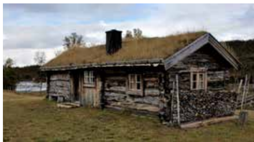
På ei anna seterstua på Enlivollen i Endalen er det brukt pipe med stålbleslag.
