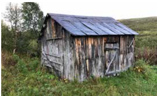
Dette flotte taket er tekket med utbankete tønner, Sverjevangen, Kvikne.
