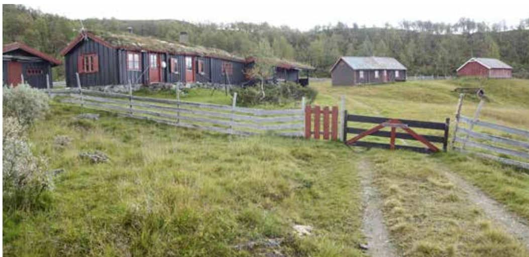
Seterstue på Langsåsvollen i Ledalen har fått ny kledning og flere tilbygg.
