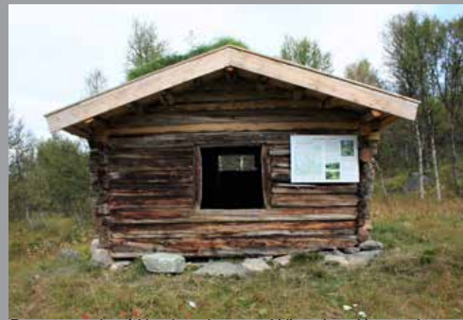
Restaurert løe i Nordgardsenget i Vingelen. Her er det brukt tømmer av furu, og takoverbygget er også relativt stort (ca 1 m).
