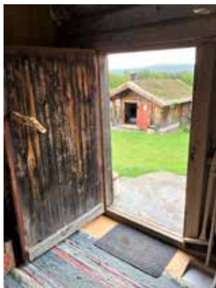
Panelt labankdør på Dalvollen, Vangrøftdalen.
