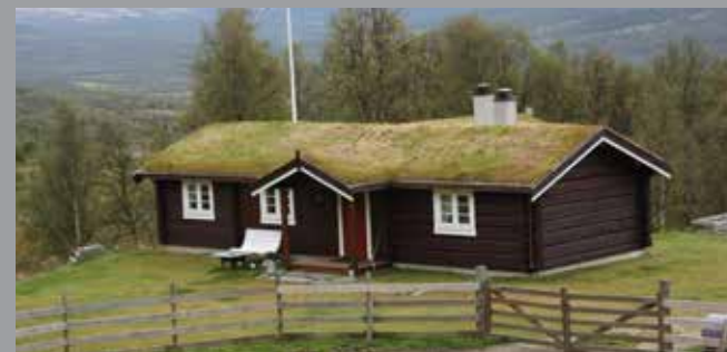
Ei ny håndlaftet seterstue har blitt beiset brun, mens tradisjonene tilsier at tømmer ikke ble behandlet.
