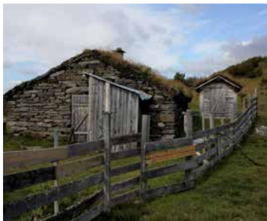
Steinfjøs har ofte ikke takutstikk og derved ingen vindskier på gavlene.
