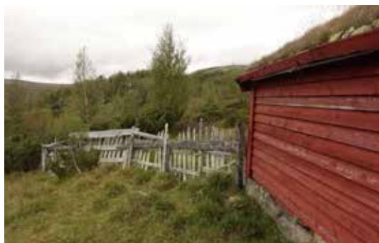
Eksempler på bruk av liggende kledning.
