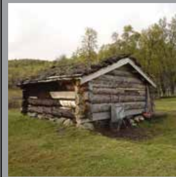
Reparasjon av tømmervegg, Buavollen i Synnerdalen
