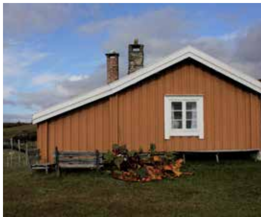
På Strømsøyvangen er det to piper, ei gammel gråsteinspipe, og ei murt teglpipe fra ca 1955.
