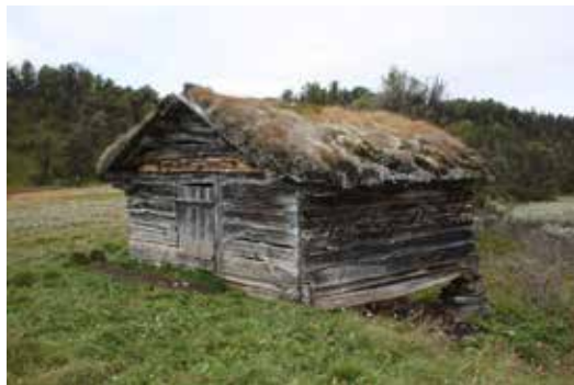
Liggende bordkledning på skjelterkonstruksjon, Storøyvolla
