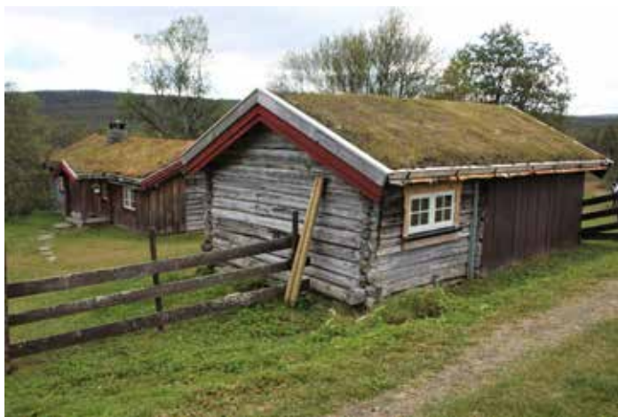
Et jevnt, og nøkternt utført vedlikehold er ofte det beste!
