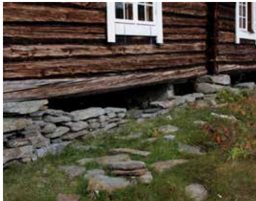
Holdsteinsmur på seterstue. Her er det holdsteinene som bærer tømmerkonstruksjonen.
