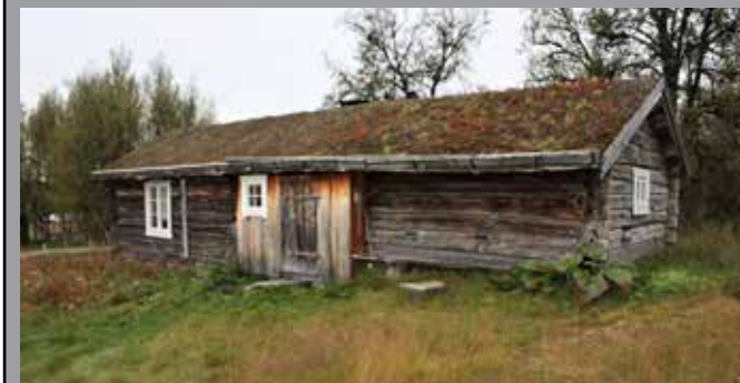
Nytt panel av god kvalitet kan gjerne stå ubehandlet. I løpet av to til tre år vil det få samme patina som de værbitte tømmerveggene.
