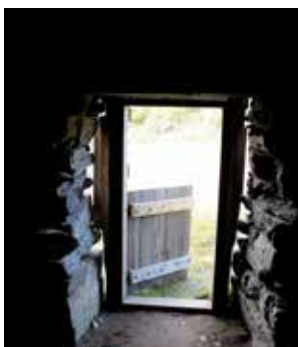
Ei todelte dør tillater lufting samtidig som dyr holdes ute.
