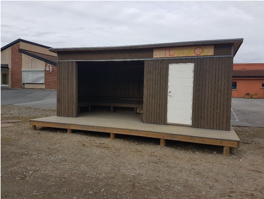
Bilde 8: Utstyrskabod. Foto: Siren Hope.
