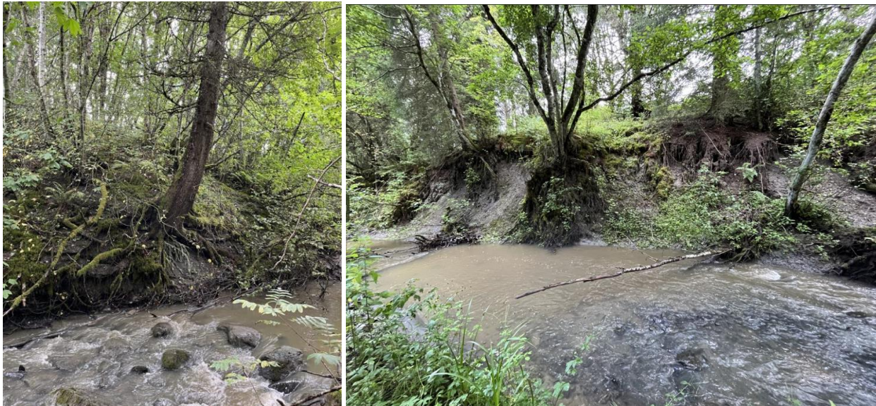
Figur 6: Erosjonsskader på nordsiden av elva og eksisterende erosjonssikring i elvebunnen.
