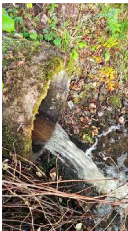
Figur 7: Kulvert 2 innløp (kom) og utløp
