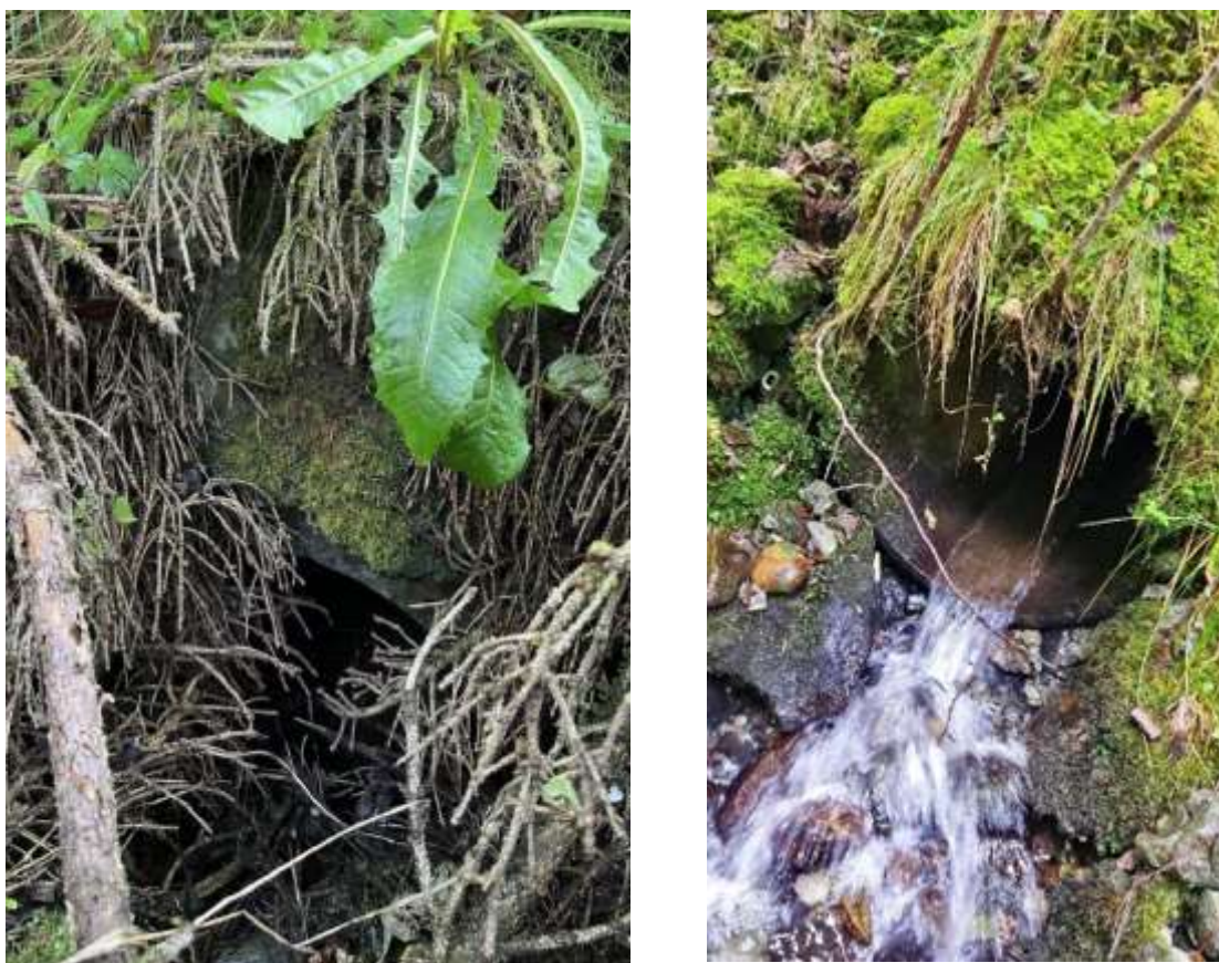
Figur 11: Kulvert 3 innløp og utløp
