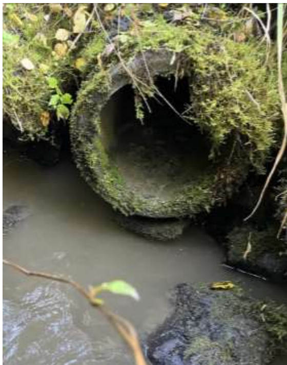
Figur 23: Kulvert 6 utløp, 400mm diameter.
