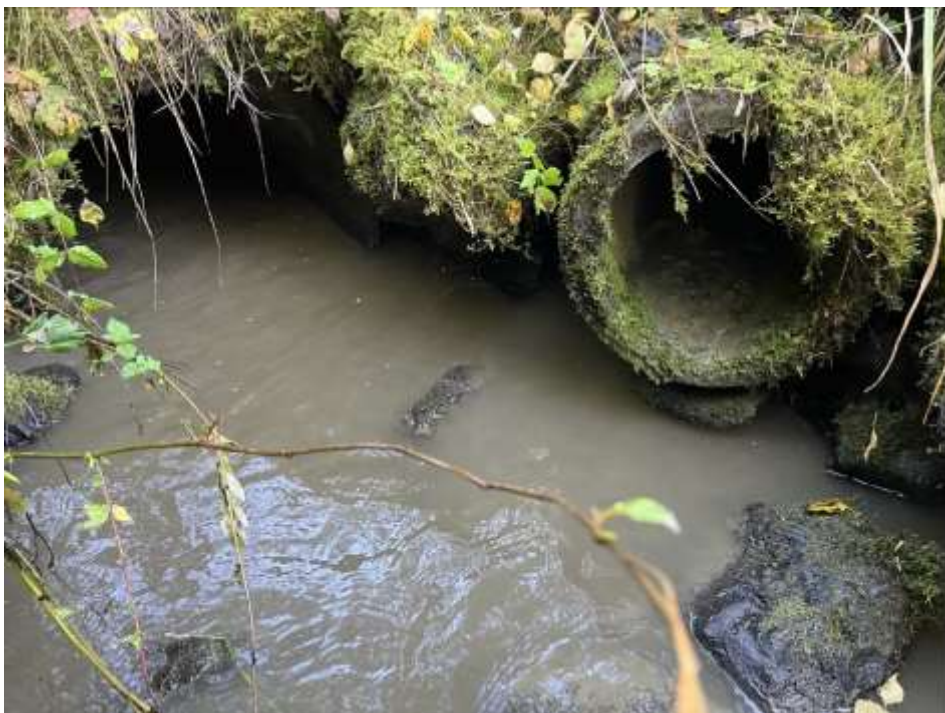
Utløp: kulvert 5 og 6
