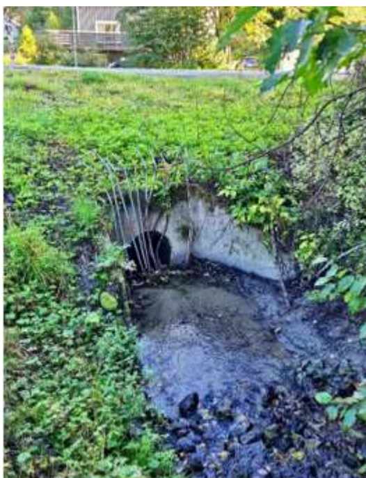
Figur 27: Kulvert 7 innløp, diameter 600mm
