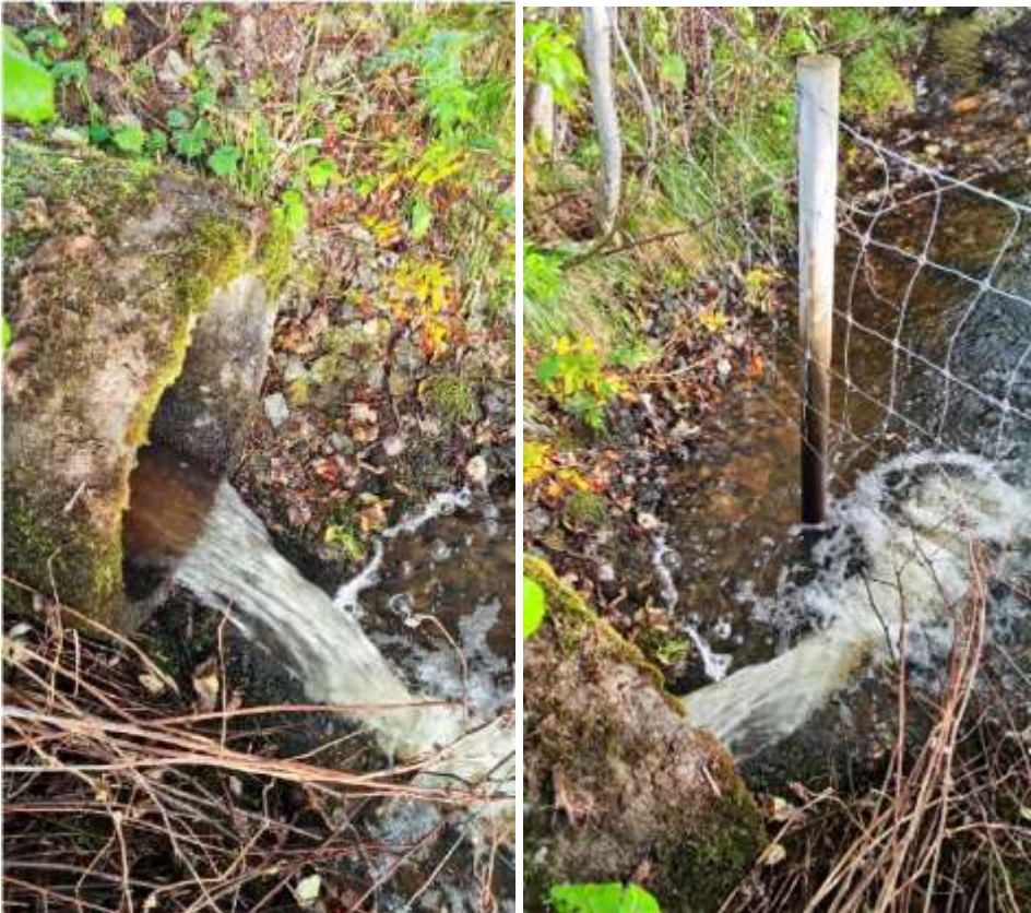
Utløp: Betongrør. Innvendig diameter 60 cm
