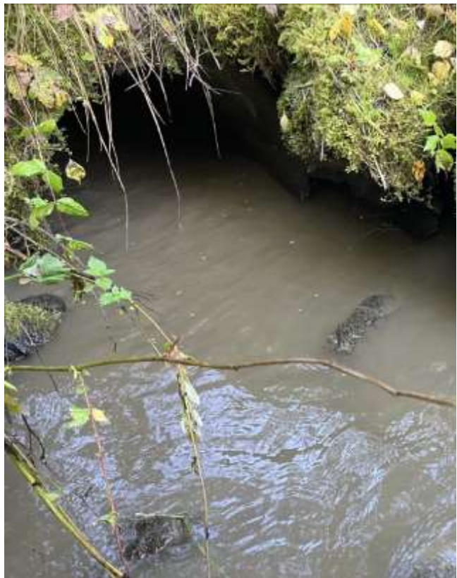
Figur 18: Kulvert 5 innløp og utløp
