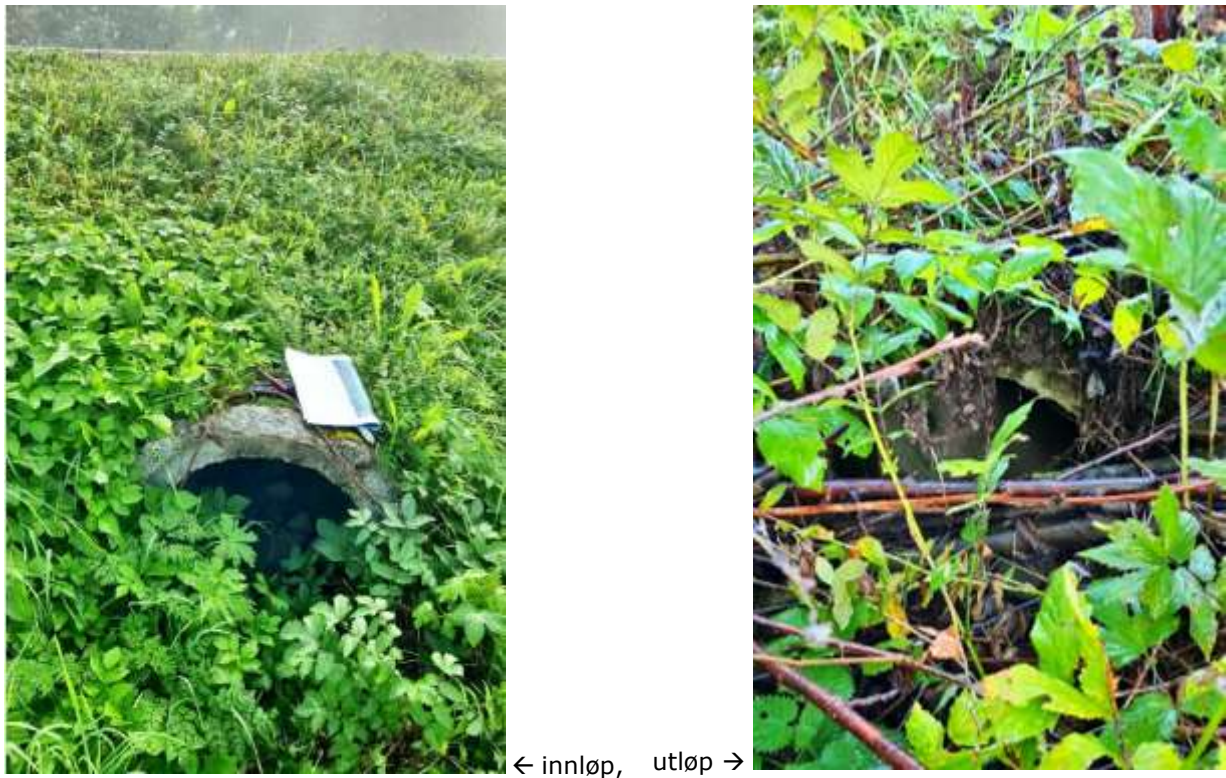
Figur 4: Kulvert 1 innløp og utløp
