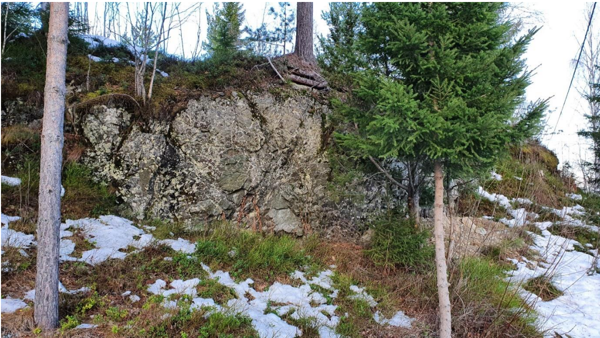
Figur 28: Nærbilde av bergskjæringen mellom profil 1360 og 1375.
