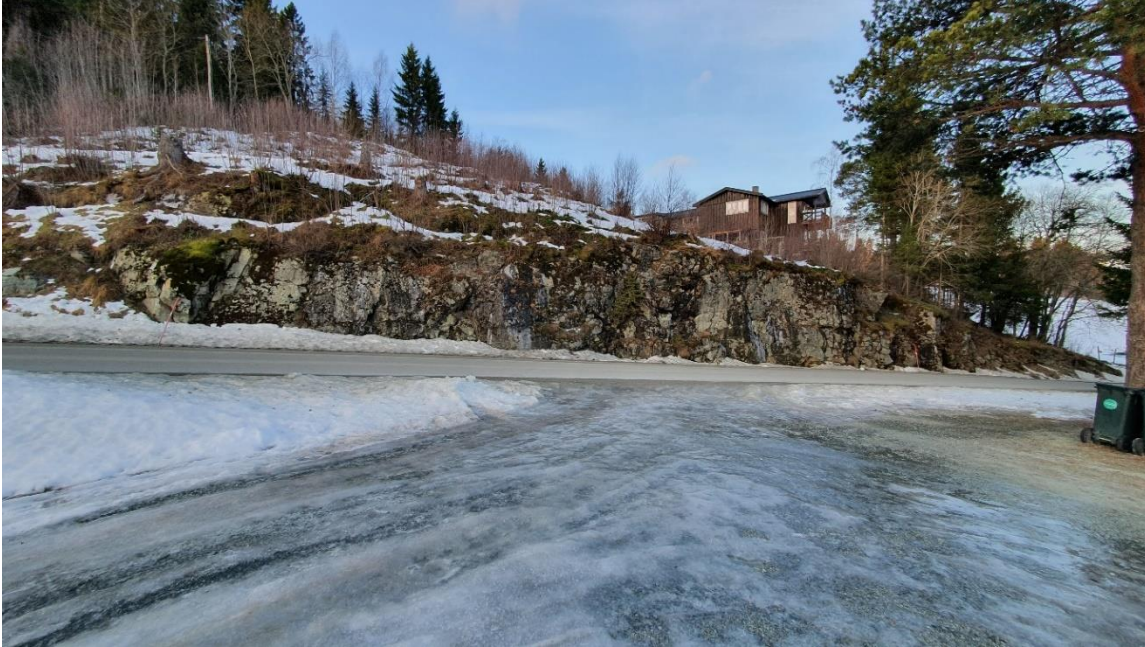
Figur 14 Oversiktsbilde av bergskjæringen mellom profil 940-1025.
