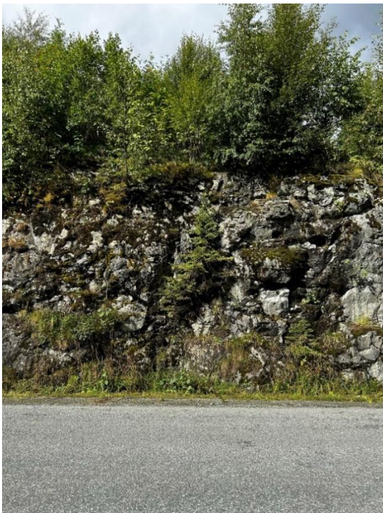
Figur 3: Bergskjæring med varierende oppsprekning fra lite oppsprukket til tett oppsprukket.
