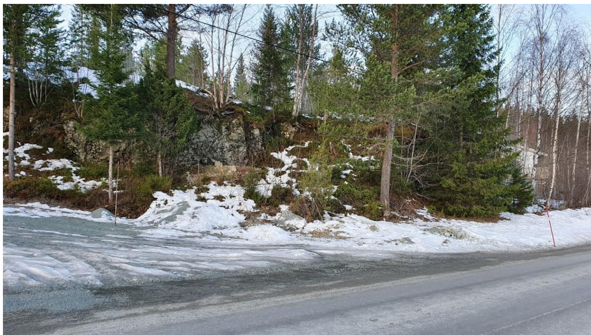
Figur 27: Oversiktsbilde av bergskjæringen mellom profil 1360 og 1375.
