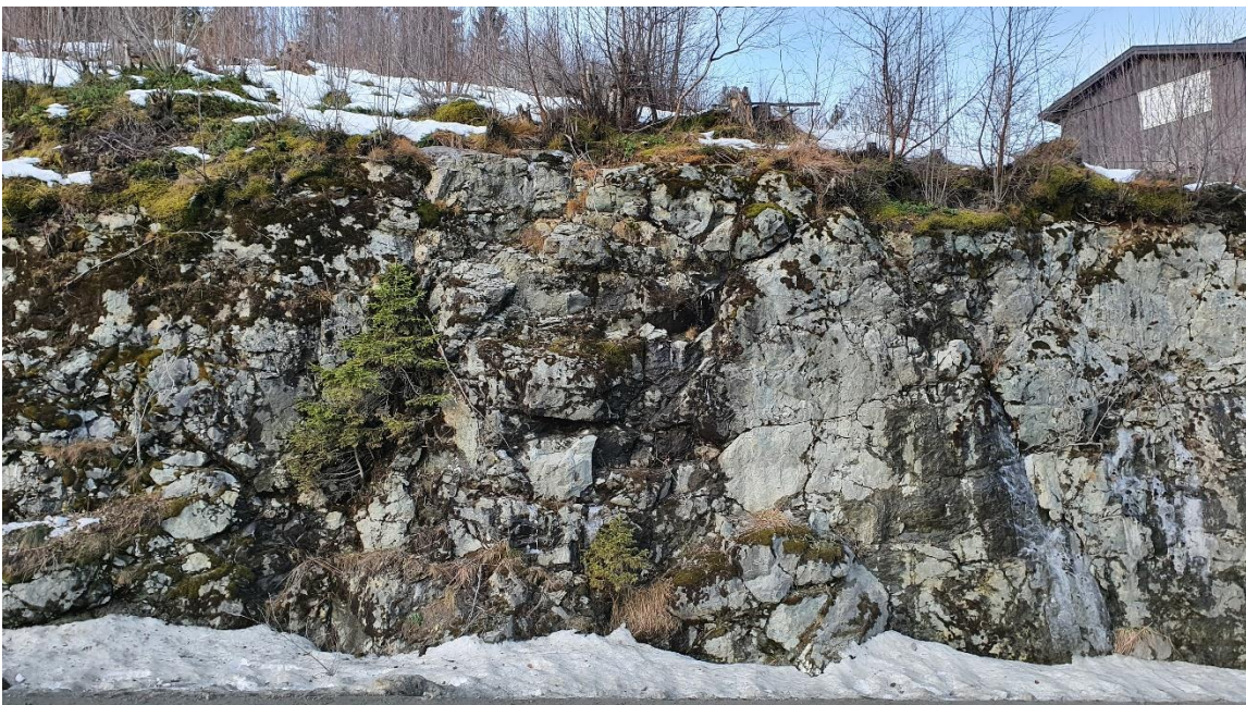
Figur 15 Nærbilde av bergskjæringen.
