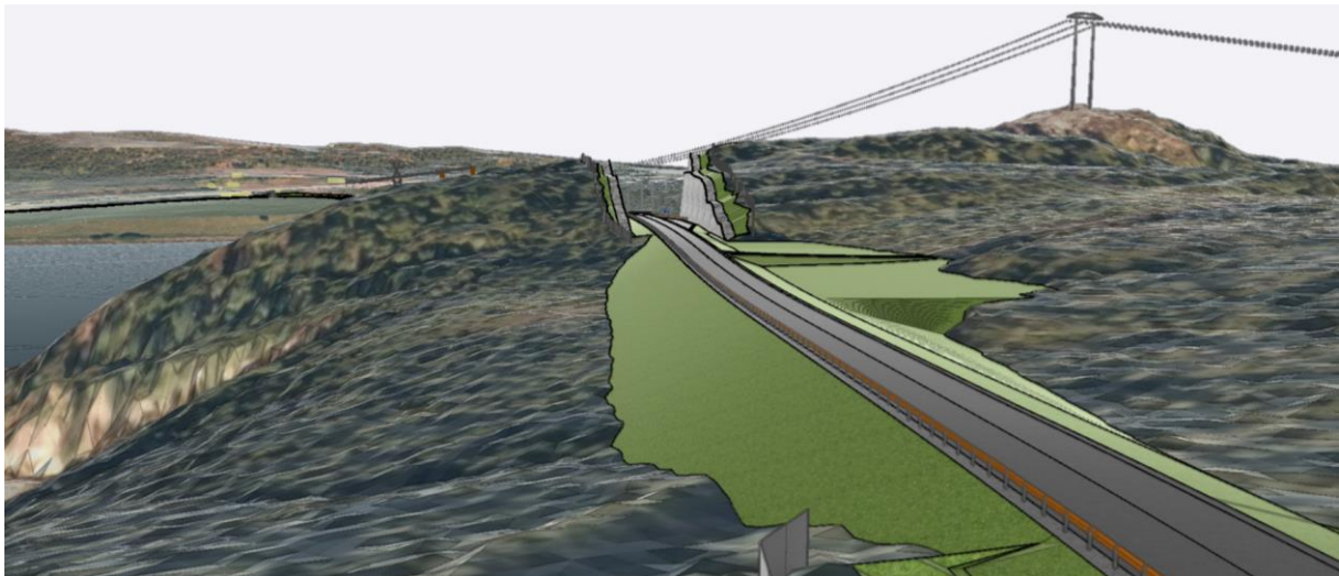
Figur 4-5 Mellom bergskjæringene går vegen på fylling fram til bergskjæring gjennom Ølhammaren, sett mot vest, i retning Jøa (Kilde: Norconsult).
