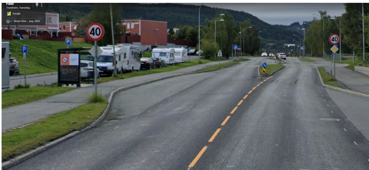
Figur 2 Busslomme Venusvegen øst for Utleirvegen
