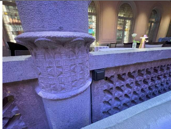
Detalj søylebase med dekor og rekkeverk
