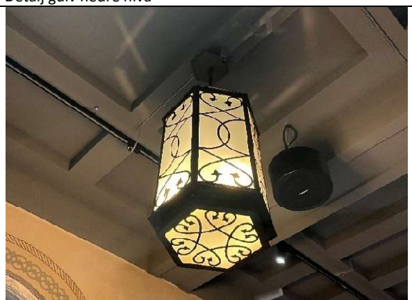
Originale kobberlykter, teknisk lagt utenpå himling
