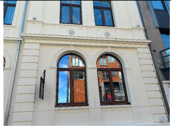
Detalj fasade, vindu og utsmykning, mot vest
