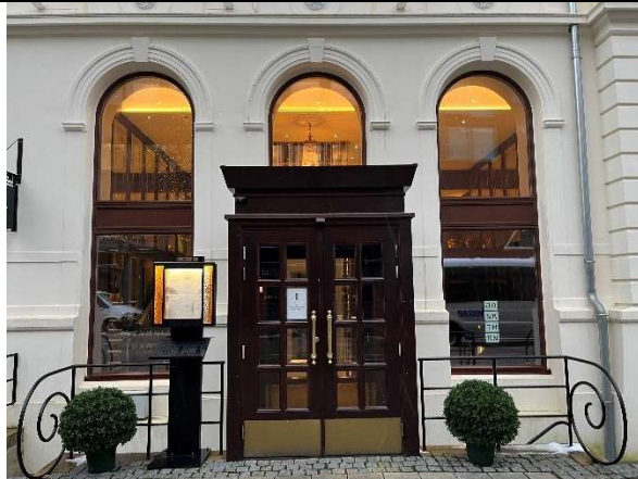
Tre av seks vinduer som er åpnet ned mot terreng
