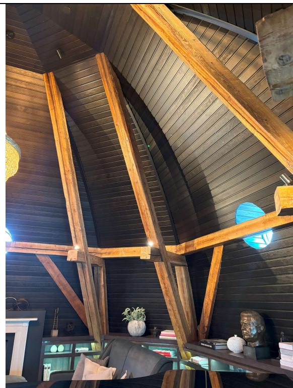
Detalj takkonstruksjon i kuppel
