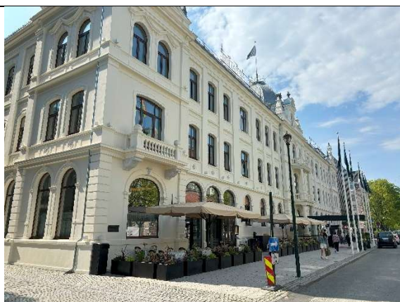
Østlig del av fasade, Dronningens gate
