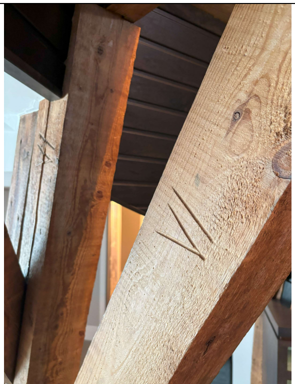
Detalj, konstruksjons-/flyttemerker på bjelker
