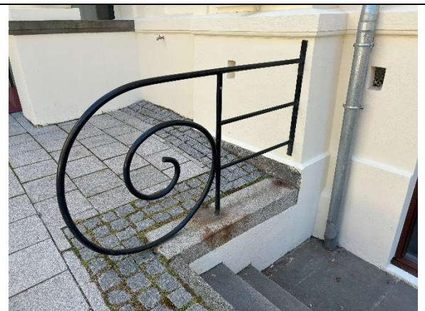
Detalj smijernsrekkverk
