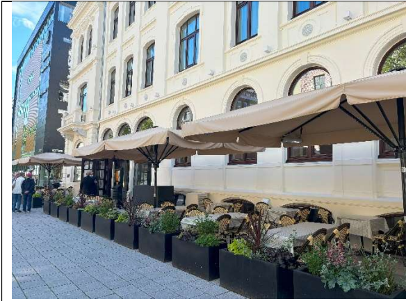
Fasade bakkenivå, uteservering østlig del av fasade
