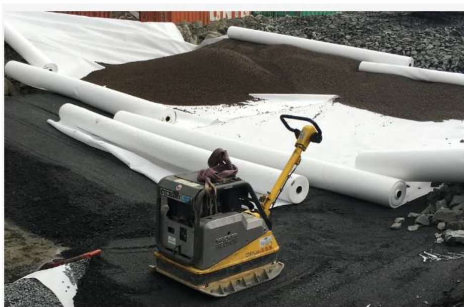
Figur 3: Bilde fra utlegging av lettlinkerfylling. (Foto: Trine Flobak, Ramboll)
