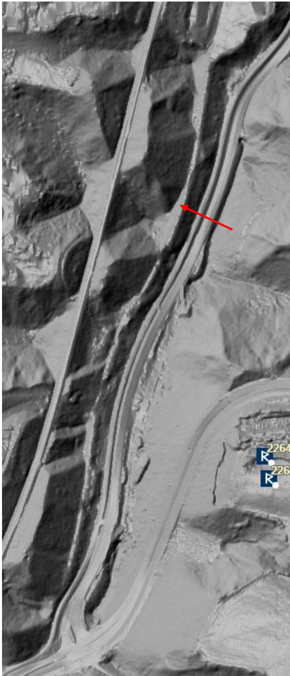
Figur 2-6. Utsnitt fra LIDAR (flylaser) viser vegfare i terrenget vist med rød pil.
