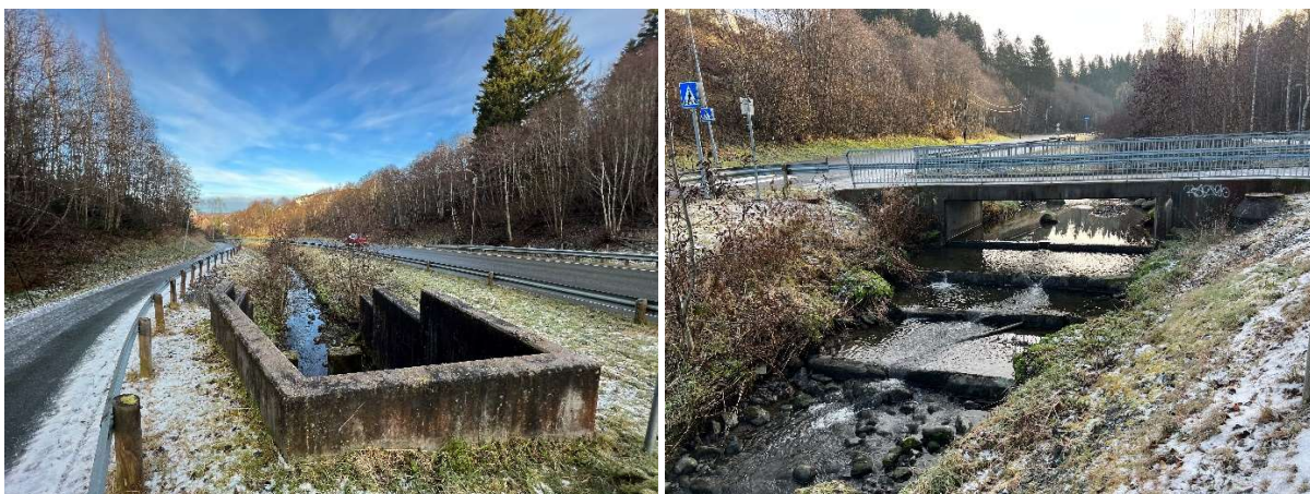
Figur 4. Dagens kulvert (høyre) som krysser under Bjørndalsveien nedstrøms Bjørndalsbrua. Dette området er anadrom grense i Heimdalsbekken. Tiltaksstrekningen avsluttes ved brua som krysser bekken ved Okstadøy (foto: Norconsult).
