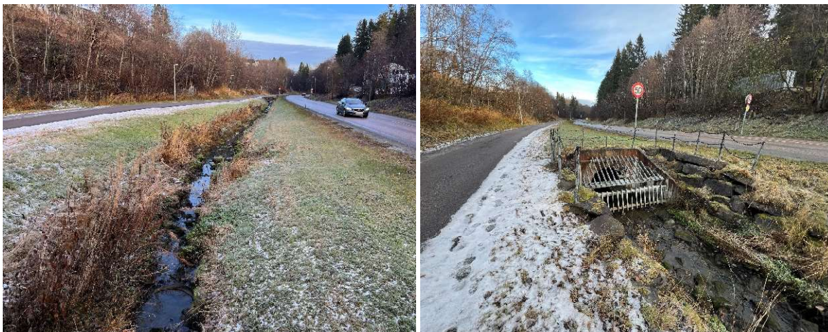
Figur 3. Bekken går åpent ned til Bjørndalen 80, hvor den fortsetter lukket i rør ca. 300 m ned til krysset Bjørndalen – John Aaes veg (foto: Norconsult).
