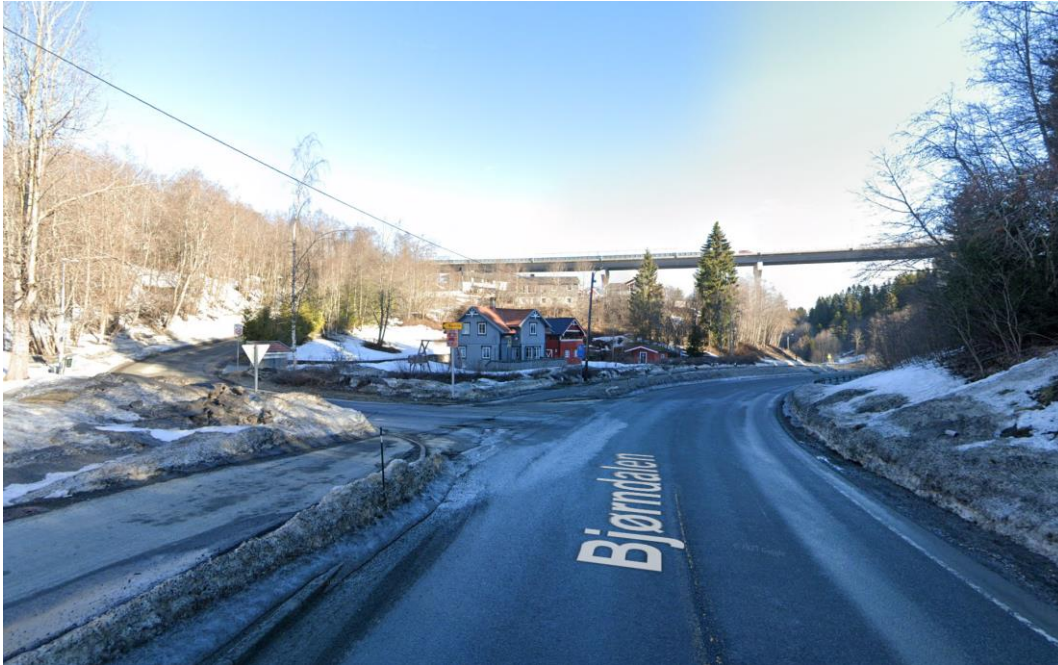
Figur 2-21: Avkjørsel Nyveilia. Sideterrenget slakes ut og kryssituasjonen åpner landskapet. Visuell kontakt med Bjørndalsbrua.
