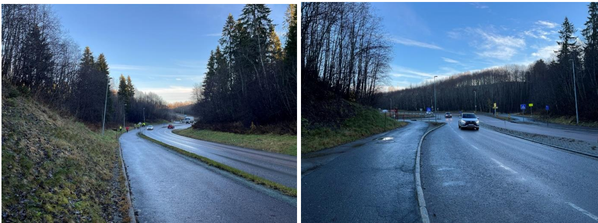
Figur 2-16: Bilder: Norconsult. Vegen inn mot krysset John Aaes veg.
