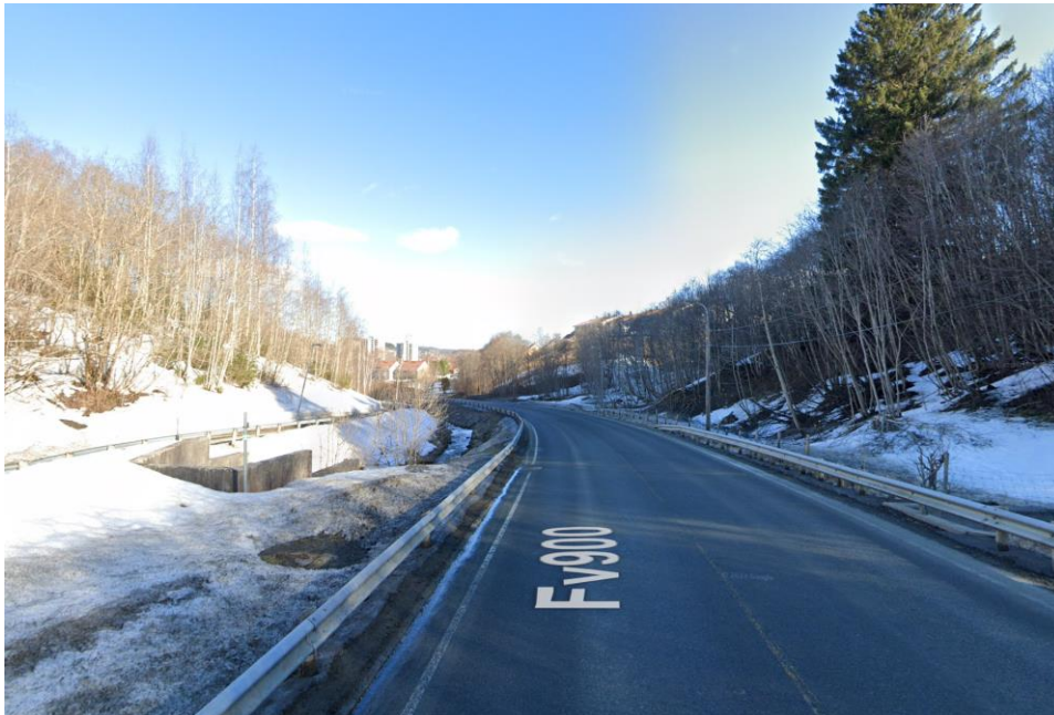
Figur 2-23: Bilde: Google maps. Bekken kommer opp i dagen.
