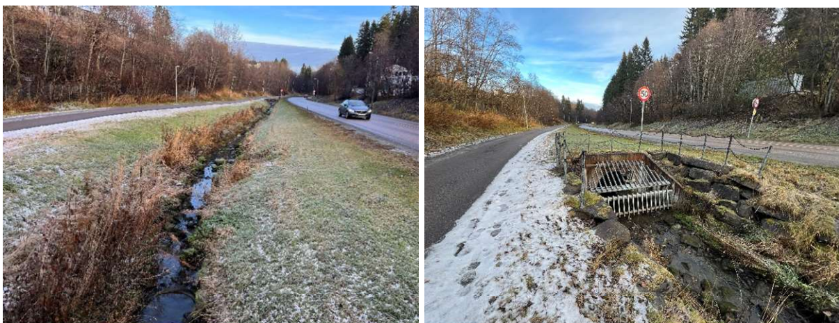
Figur 3-6. Bekken går åpent ned til Bjørndalen 80, hvor den fortsetter lukket i rør ca. 300 m ned til krysset Bjørndalen – John Aaes veg (foto: Øistein Hveding).
