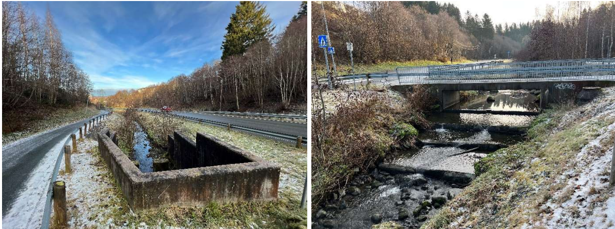
Figur 3-8. Bildet (venstre) viser kulvert som krysser Bjørndalsveien rett nedstrøms Bjørndalsbrua. Det er planlagt dagens kulvert som krysser under veien skal byttes ut og optimaliseres for fiskevandring. Delområdet avsluttes ved brua som krysser bekken ved Okstadøy (høyre).
