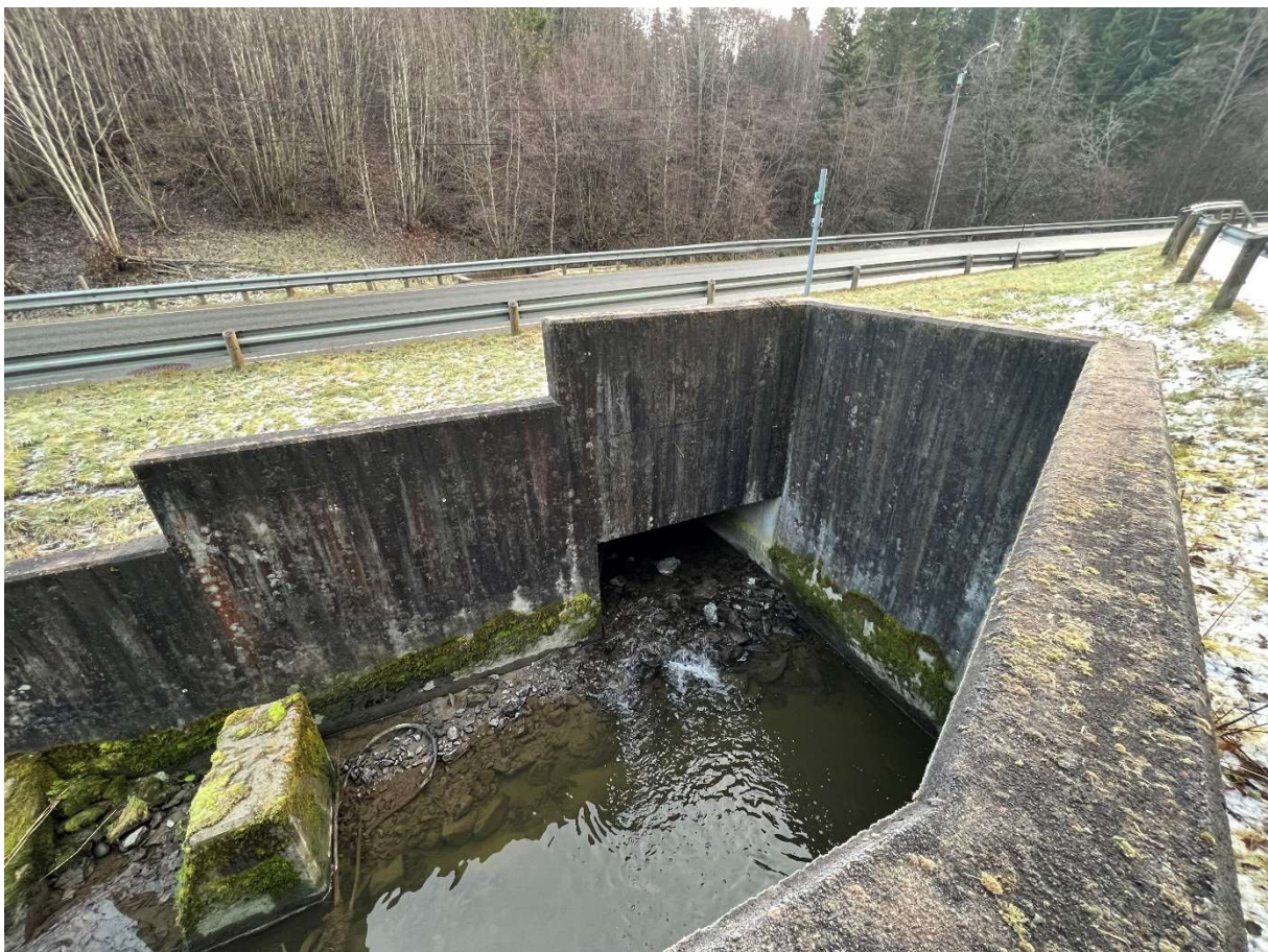
Figur 3-9. Bildet viser utløpet fra dagens kulvert som krysser under Bjørndalsveien. Denne kulverten planlegges skiftet ut og optimalisert for fiskevandring med naturlig bunn.
