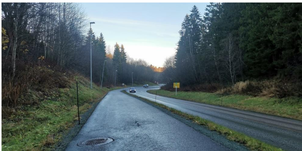
Figur 1-2: Bjørndalen sør for krysset Bjørndalen - John Aaes veg, sett nordover (Norconsult 2022)
