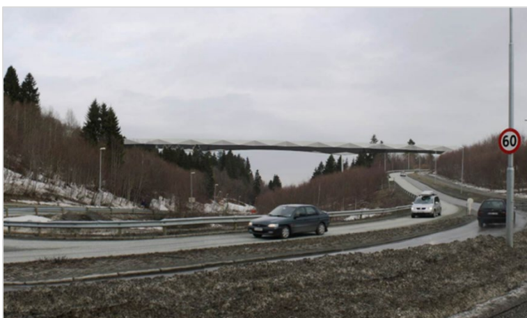
Figur 9 Oversiktsbilde Saupstadbrua, sett fra krysset John Aaes veg - Bjørndalen (kilde: Miljøpakkens prosjektside 4 )
