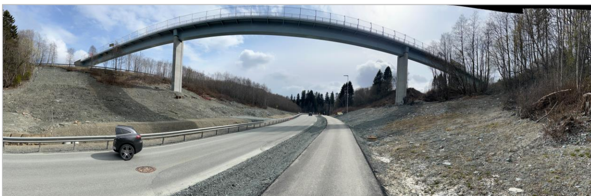
Figur 2-4: Fylkesveg 6682 Bjørndalen, gang- og sykkelveg og sideterreng er hevet i forbindelse med bygging av gang- og sykkelbru over dalen.
